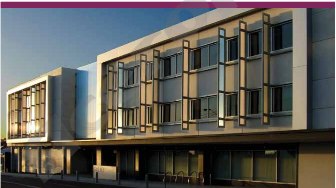
Oficinas de Servicios Comunitarios, Charlestown Australia | Sistema de cortasoles de Danpal® | Arquitectos: Jackson Teece
