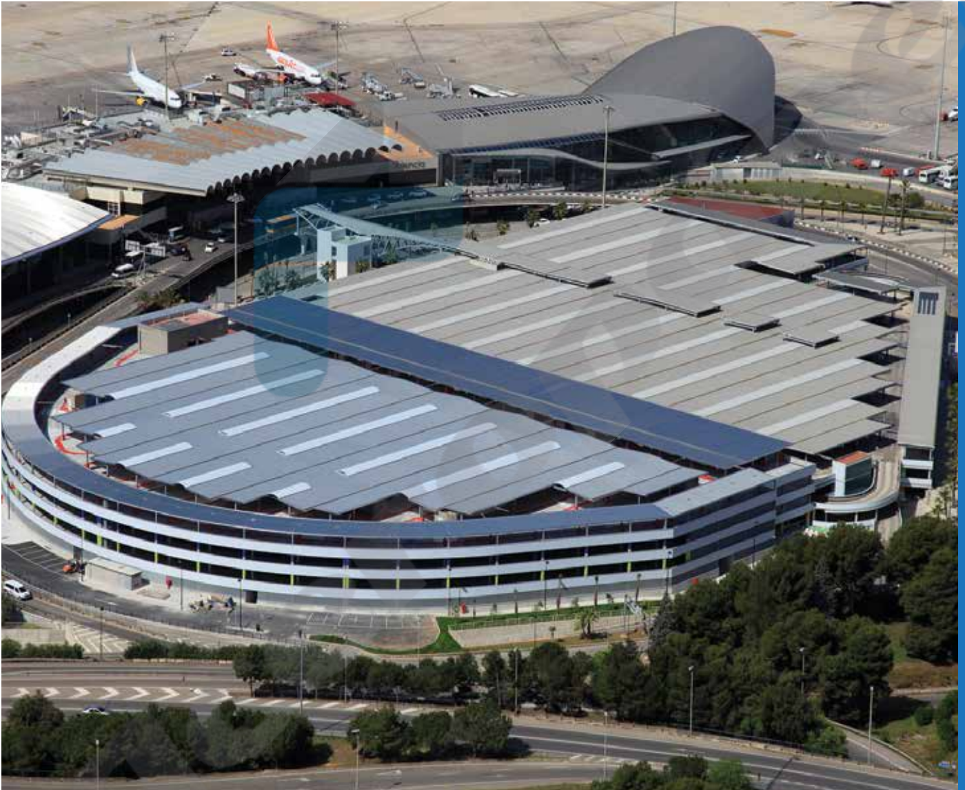
PARKING AEROPUERTO DE VALENCIA, Valencia (España) | Sistema Danpavault
